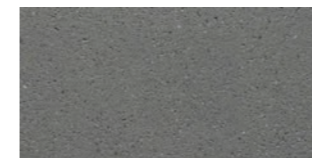
Fussboden Hartbetonbelag abgezogen und geglättet, grau
