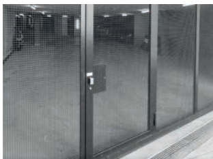
Garagentor, z.B. Daro Tor, Schiebefalttor 2+2 automatisch Torsegmente Stahlrahmen mit Füllung Wellengitter Schiebefalttor 2+2 automatisch
